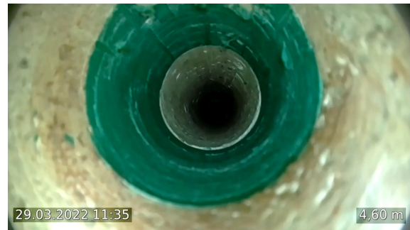
Abbildung 32: Ergebnis des Ausbohrens mit einer zentrierten Führung der Bohrkronen
