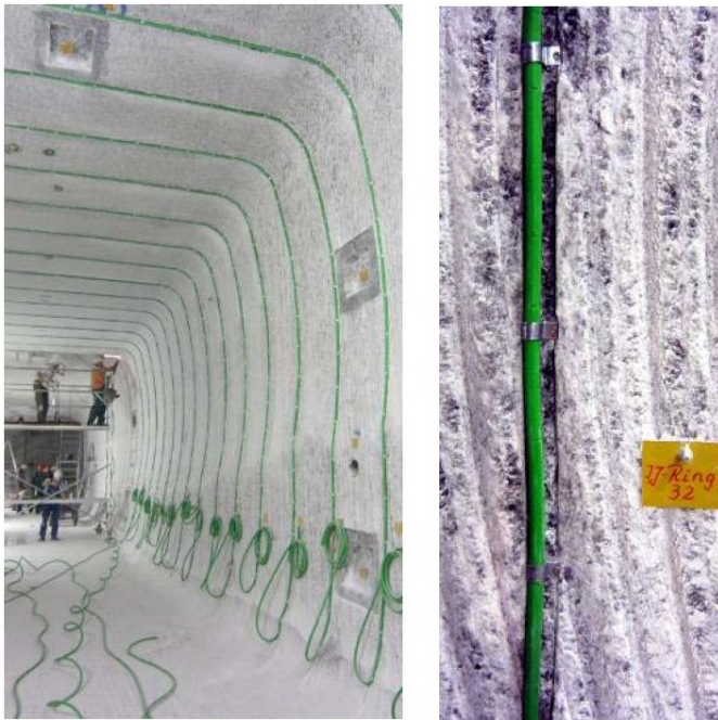
Abbildung 33: Injektionsinstallation im ERA Morsleben [9]
