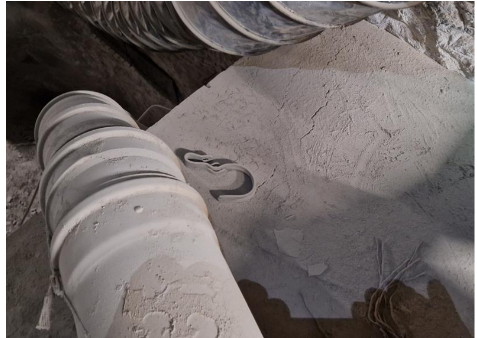
Abb. 9: Damm Zustand linke Ecke 07.02.20
