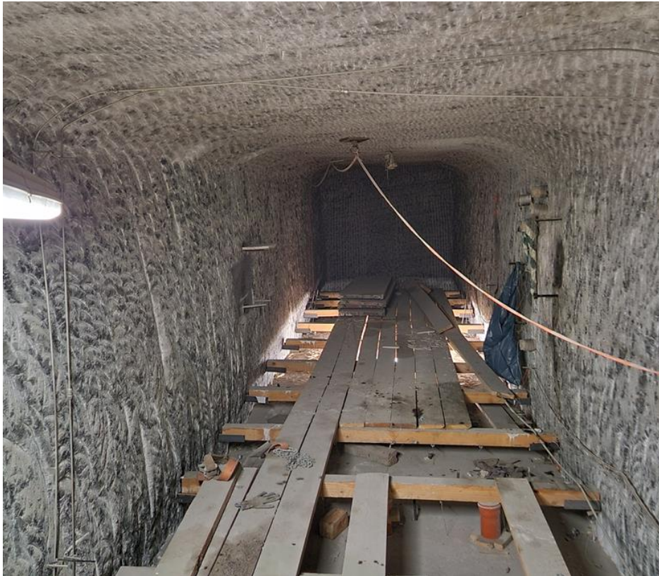
Abb. 12: Überblick der Dammoberfläche (hinterer Teil)
