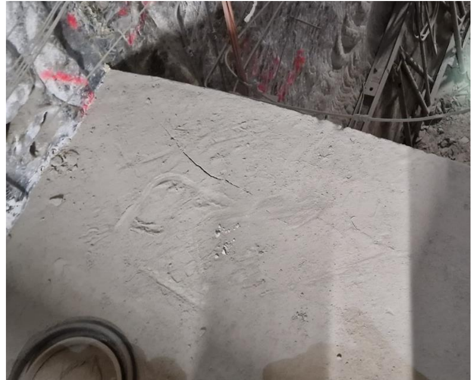
Abb. 7: Damm Zustand rechte Ecke 07.02.2023
