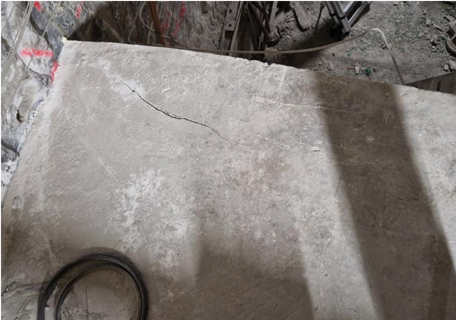
Abb. 10: Damm Zustand rechte Ecke 28.02.2023
