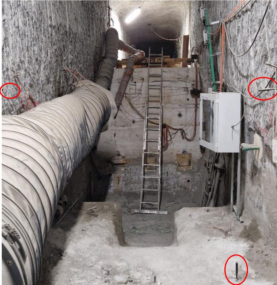
Abb. 2: Überblick der Dammortsbrust (vertikale und horizontale Konvergenzmesststelle rot markiert)
