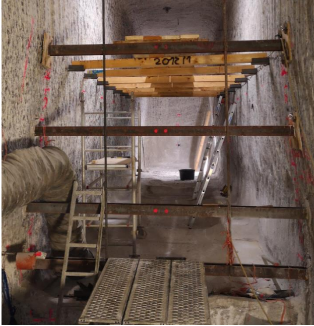
Abbildung 73: I-Träger der Schalung
