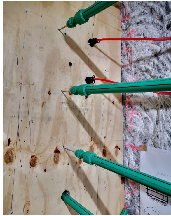
Abbildung 47: Rohranschlüsse an der Schalung
