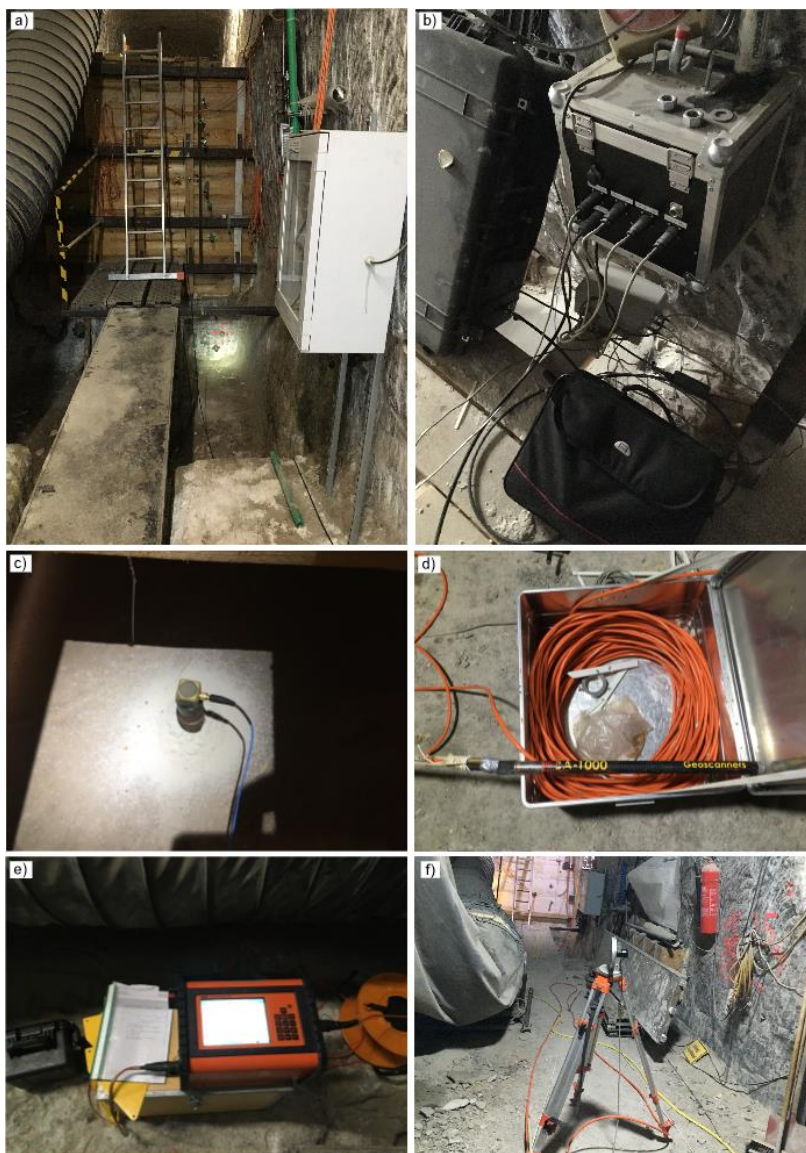
Abbildung 82: a) Dammbauwerk mit den Bohrlöchern für die Geoelektrik, unten links, und Bohrlochradar, unten rechts. Beide Bohrlöcher wurden im Salzgestein unterhalb des Dammbauwerkes abgeteuft, b) Schutzkiste des Datenrekorders der Mikroseismik imc Cronos Flex mit Kabelanschlüssen zu den Schwingungsmessern, c) auf dem Dammbauwerk verschraubter Beschleunigungsaufnehmer Hersteller PCB, Modell 356B18, d) Bohrlochradarantenne Fa. Geoscanners, Modell BA1000 mit 1000 MHz mit Kabel, e) Geoelektrik Steuer Einheit Fa. ABEM Terrameter LS, f) Messrad für die Bohrlochradarmessung
