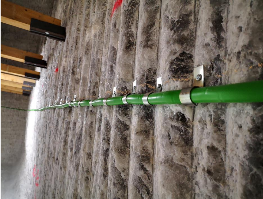
Abbildung 37: Befestigung der Injektionsleitungen am NW-Stoß
