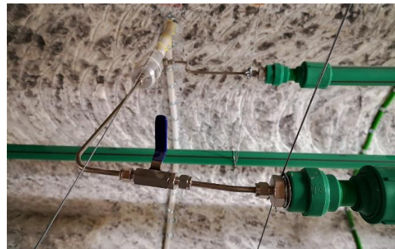
Abbildung 49: Rohranschlüsse an den Ringkammern
