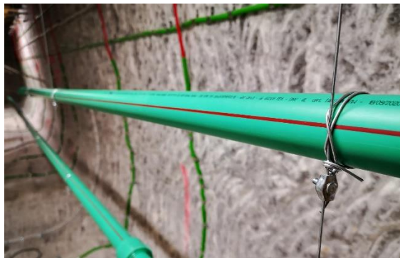
Abbildung 48: Rohrfixierung am Spanndraht (Rohr noch ungeschliffen)
