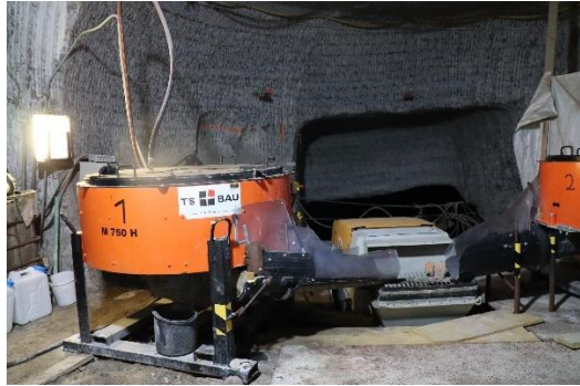
Abbildung 60: Übersicht über die eingesetzte Mischtechnik
