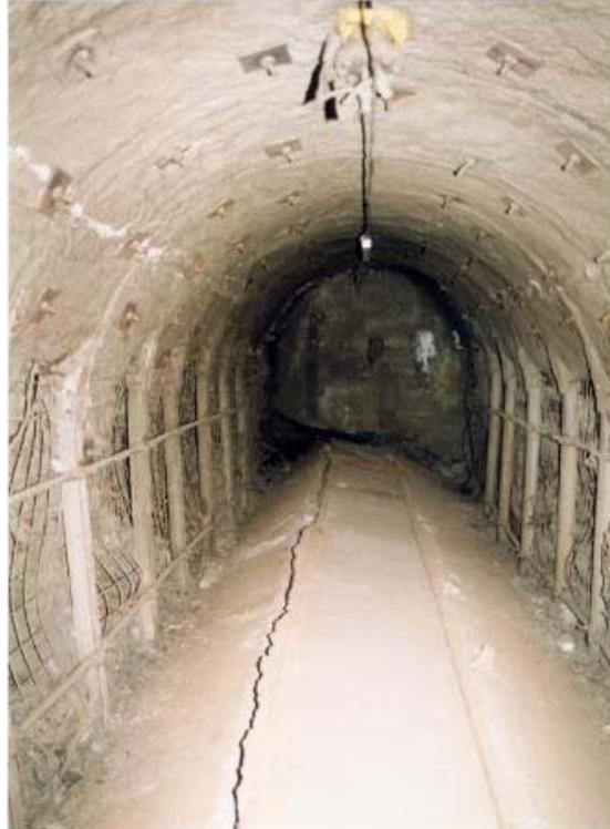
Abbildung 6-2: Schachtanlage Konrad - Ehemalige Untersuchungsstrecke (Teufe – 541 m) mit geschraubten Stahlbögen und Anker-/Spritzbetonausbau in der Firste
