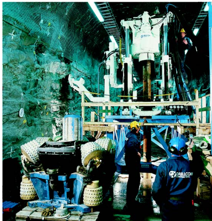
Abbildung 6-4: Erstellung von Einlagerungsbohrlöchern in ONKALO [Posiva]
