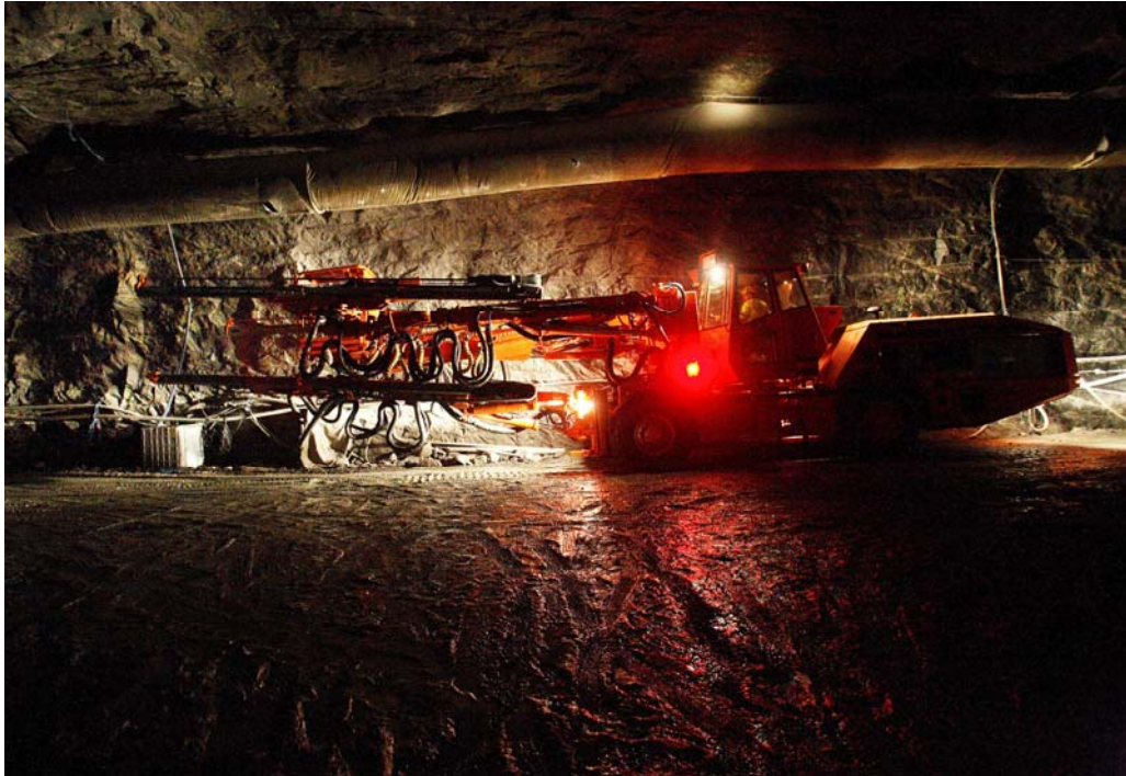
Abbildung 6-3: Erstellung von Sprengbohrlöchern in der Rock Characterization Facility ONKALO [Posiva]
