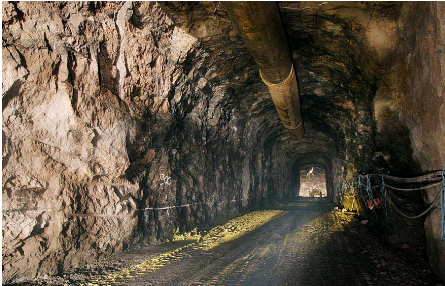
Abbildung 6-2: Rampe der Rock Characterization Facility ONKALO mit Anker- und Netzsicherung der Streckenwandung, Finnland [Posiva]
