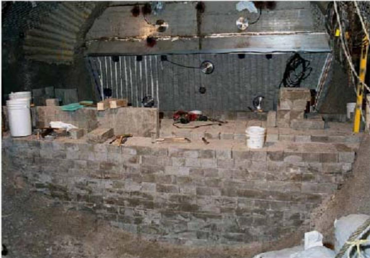
**Abbildung 3-21: Großversuch TSX zur Errichtung des Dichteelementes eines Streckenverschlusses im kanadischen Untertagelabor /3-29/**
