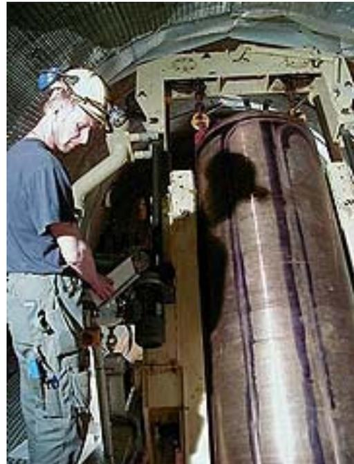
**Abbildung 4-18: Prototyp eines Geräts zum Einbringen von Bentonitelementen in die Einlagerungsbohrlöcher /4-36/ (links), Versuchseinlagerung eines Endlagerbehälters im Untertagelabor in Äspö (rechts).**
