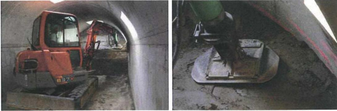
**Abbildung 3-19: Versuche zur Streckenverfüllung im Untertagelabor Bure (Meuse/Haute-Marne, Frankreich)**
