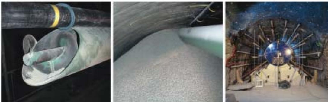
**Abbildung 3-32: Großversuche zur Verfüllung von Einlagerungsstrecken**
