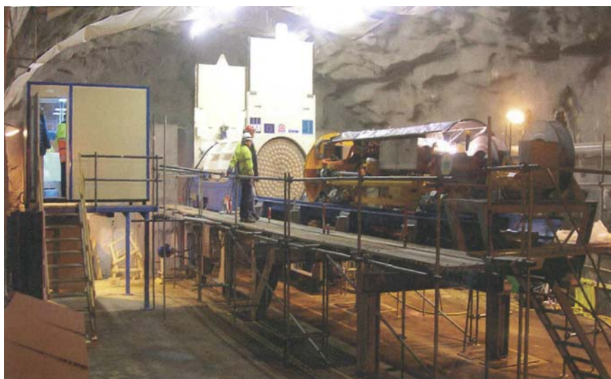
Abbildung 5-26: Erprobung der Einlagerungsmaschine für Supercontainer im Untertagelabor Äspö – Schweden /5-5/
