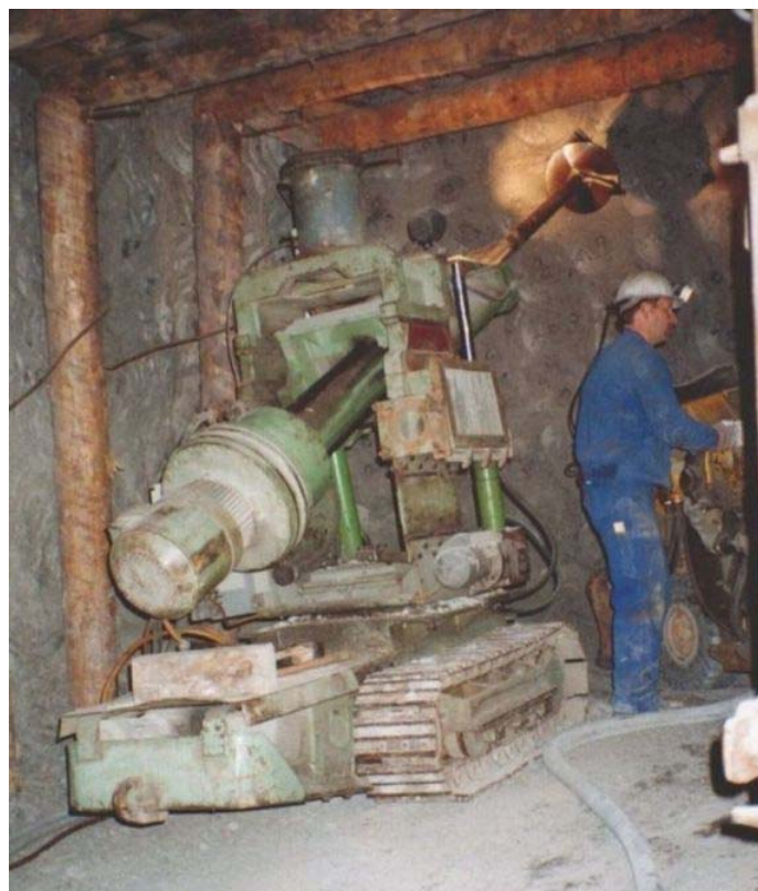
Abbildung 3-17: Tonbohrmaschine „Vetter“ in der Grube Lengemannschacht – Deutschland /3-21/
