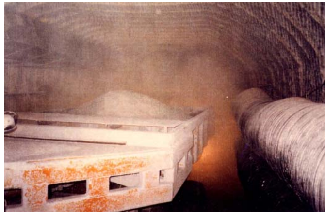
Abbildung 5-49: Streckenverfüllung mit einem Schleudertruck – Deutschland /5-9/
