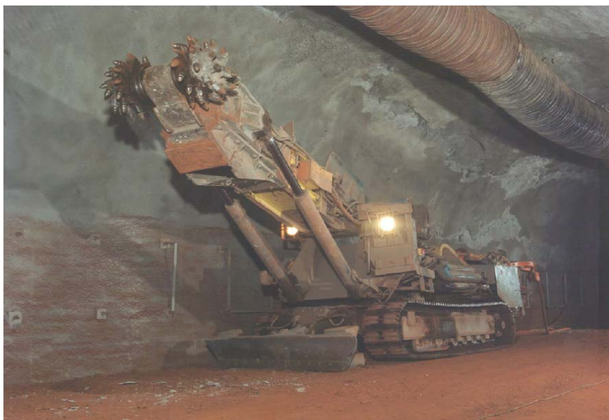
Abbildung 3-31: Teilschnittmaschine im Salz – Deutschland
