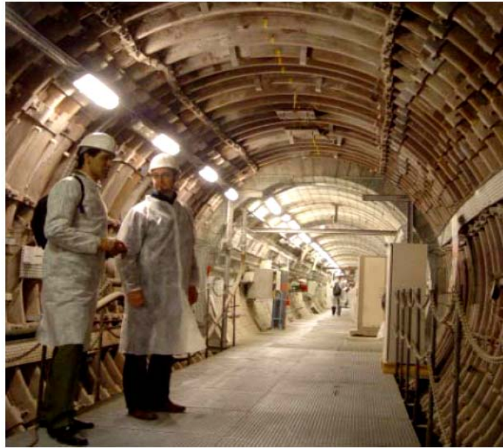
Abbildung 3-24: Engständiger Ausbau mit Stahltübbing, Untertagelabor HADES – Belgien /3-26/
