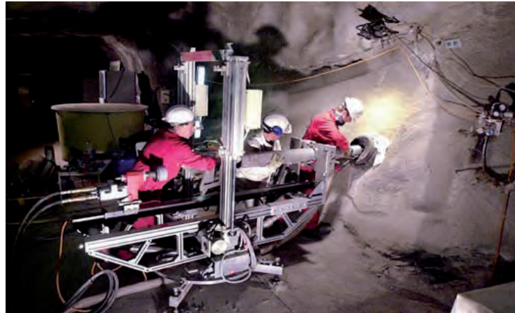
Abb. 59: Unter-Tage-Photo zur Durchführung eines Überbohrversuches im URL Mont Terri (Quelle: BGR)
