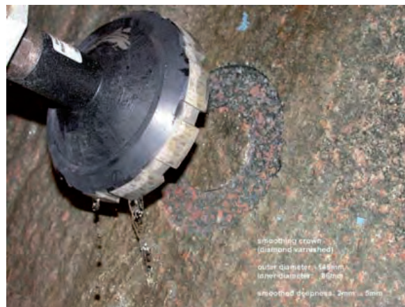
Abb. 89: Vorbereitung eines hydraulischen Tests zur Bestimmung der hydraulischen Durchlässigkeit der Auflockerungszone mittels Oberflächenpacker im URL Äspö (Quelle: BGR)
