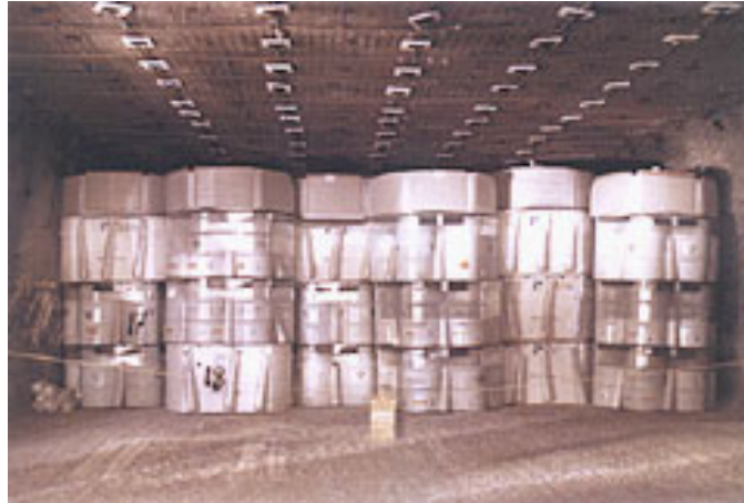
Abbildung 2-28: Einlagerungsstrecke mit CH-TRU-Endlagerbehältern
