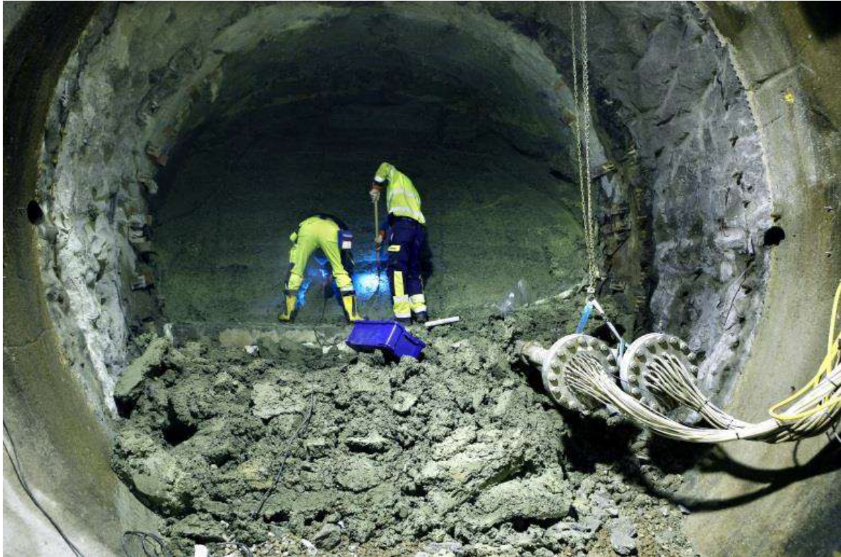
Abbildung 4-9: Ausbau von Bentonitverfüllmaterial nach ca. 10 Jahren aus dem Opalinuston, Fries (2013)
