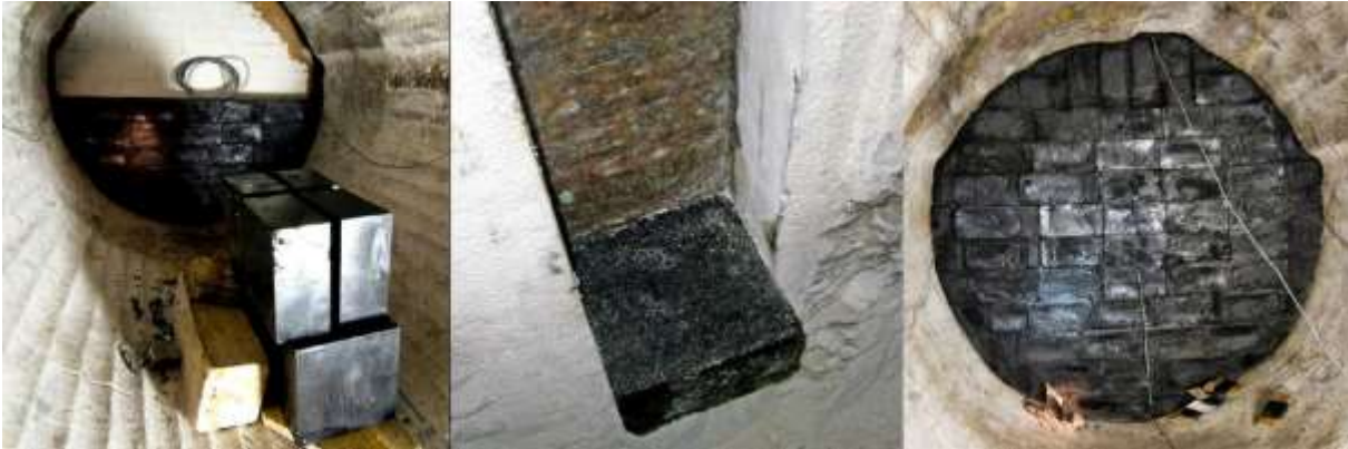
Abbildung 5-24: links: Einbau der Asphaltsteine, mitte: Gebirgsschlitz mit Voranstrich und Asphaltstein, rechts: fertige Asphaltmauerung vor dem Einbau des Druckkissens, nach Knoll et al. (2010)
