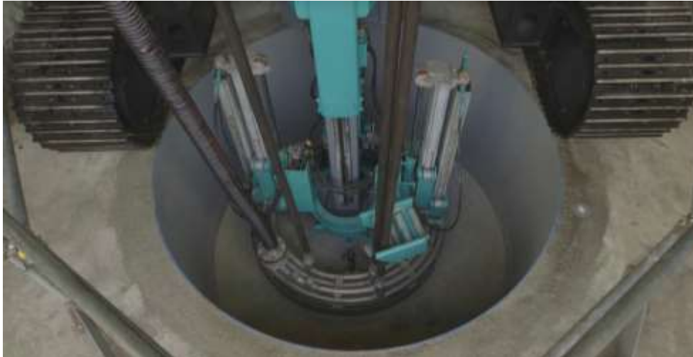
Abbildung 6-9: Blick ins Testbohrloch (RWMC, 2019)
