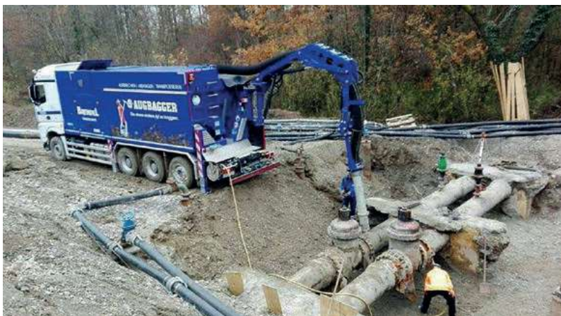
Abbildung 4-20: Saugbagger mit Saugleitung und Behälter für mehrere Kubikmeter Aushub, MTS (2020)
