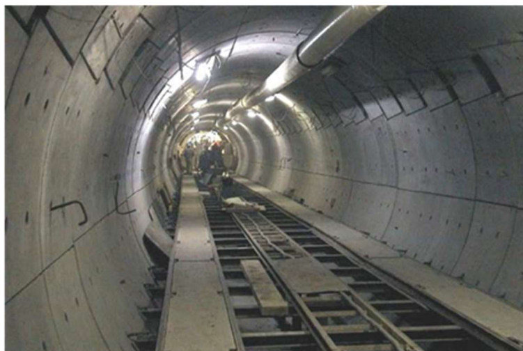
Abbildung 2-25: HADES Tübbingausbau (Bastiaens et.al, 2003)
