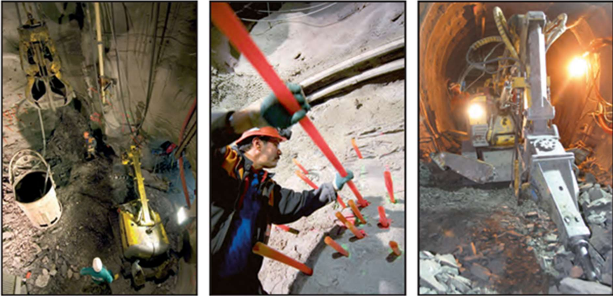
Abbildung 2-39: Vortriebsarbeiten im Untertagelabor Meuse/Haute-Marne (von links nach rechts: a) Abteufen des Schachts, b) Vortrieb auf Sohle 445 m, c) Vortrieb auf Sohle 490 m) (ANDRA, 2005b)
