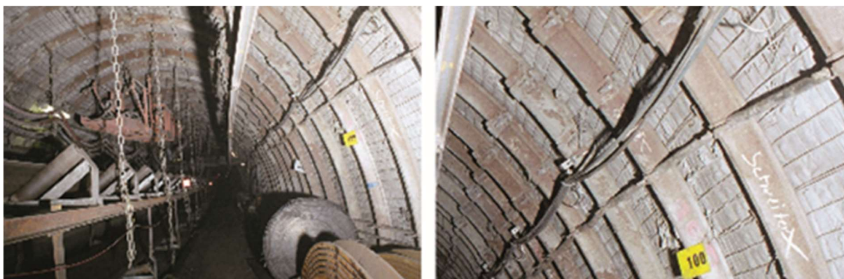
Abbildung 2-5: Baustoffhinterfüllte Gleitbogenstrecke (Junker et. al., 2006)
