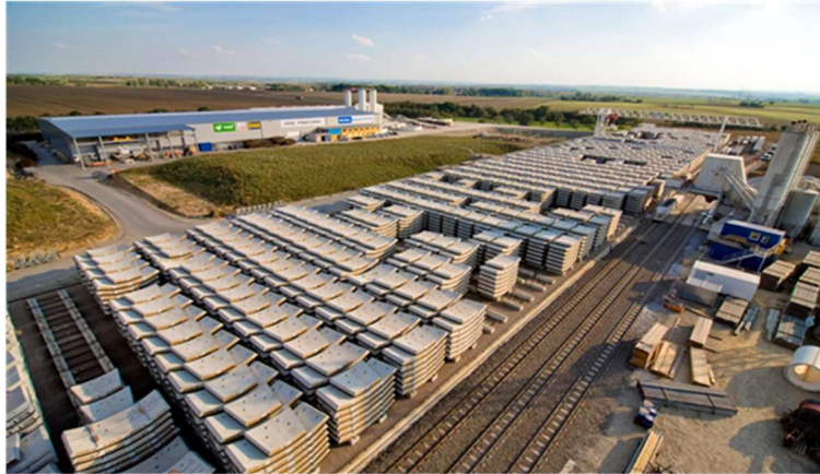
Abbildung 2-20: Boßlertunnel Tübbingfabrik und -lager (Breidenstein, 2012)
