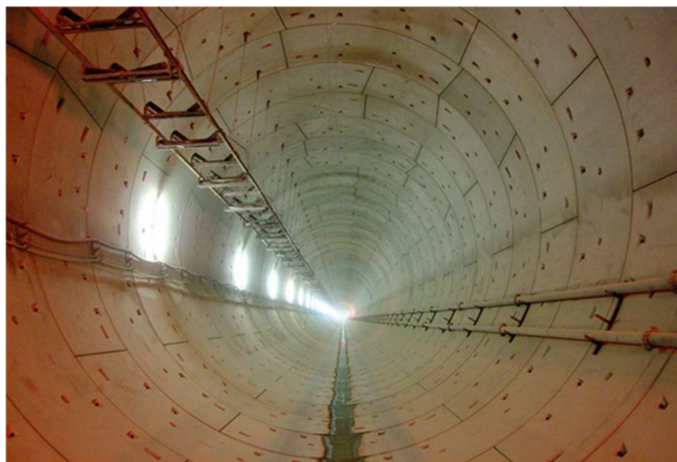
Abbildung 2-19: Boßlertunnel Tübbingausbau (Breidenstein, 2012)
